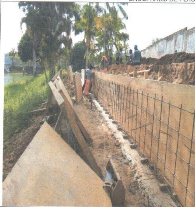
ENCOFRADO Y VACIADO DE MORTERO EN PLACAS DE CONTENCIÓN
