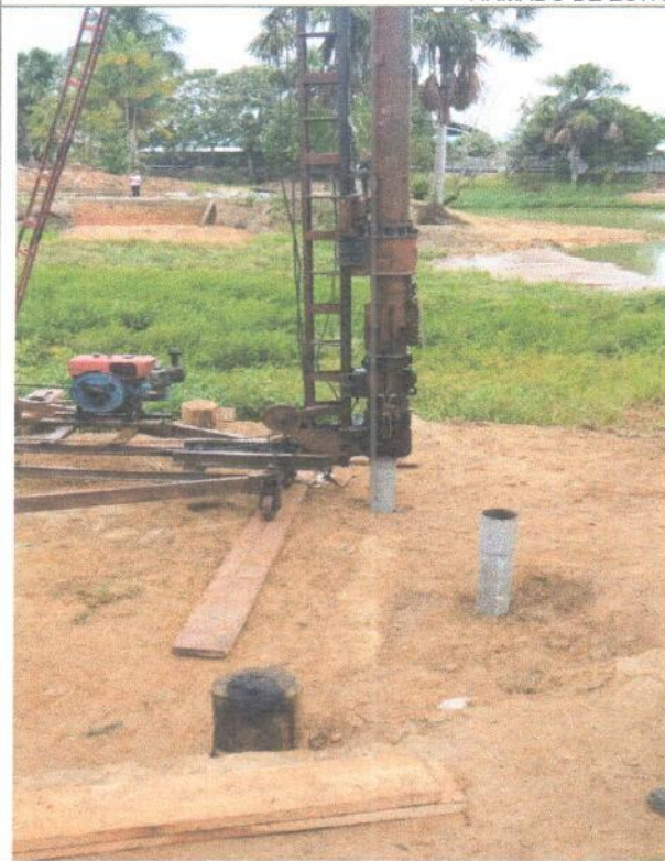
COLOCACION DE PILOTES
