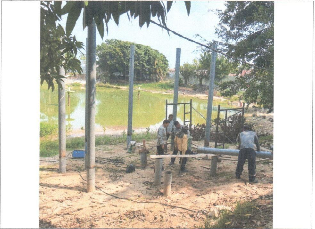
ARMADO DE ESTRUCTURA DE MALOCAS
