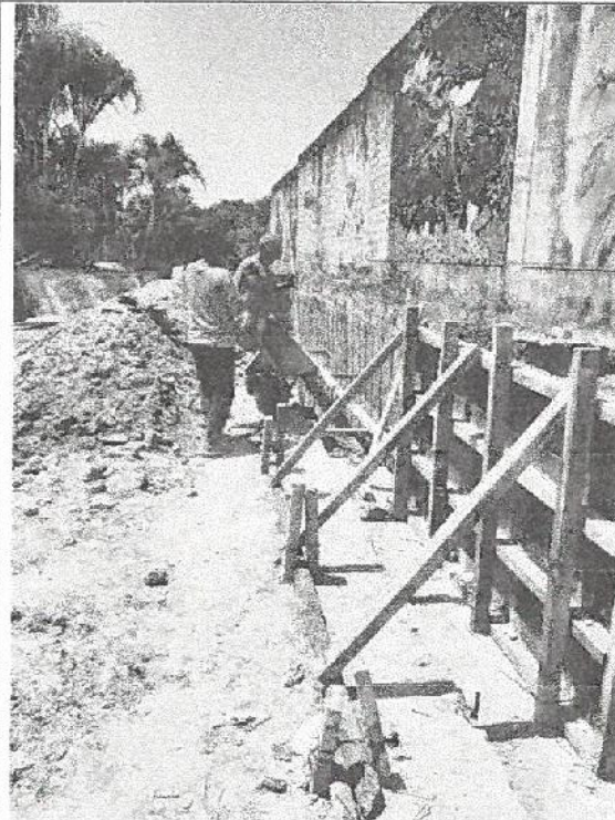
ENCOFRADO DE SARDINEL ARMADO
