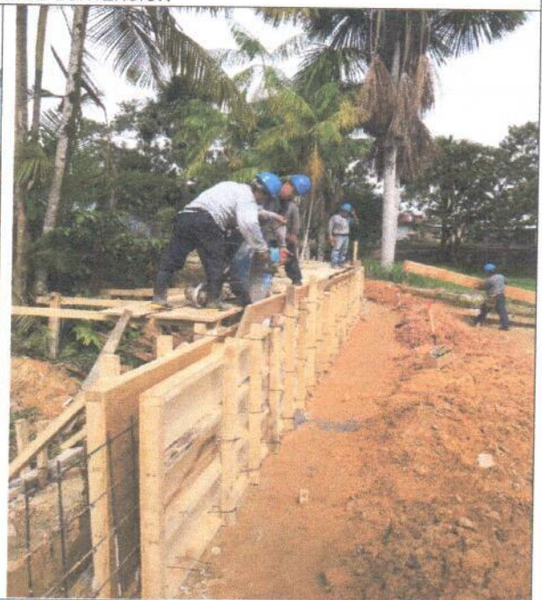
ENCOFRADO Y VACIADO DE MORTERO EN PLACAS DE CONTENCIÓN
