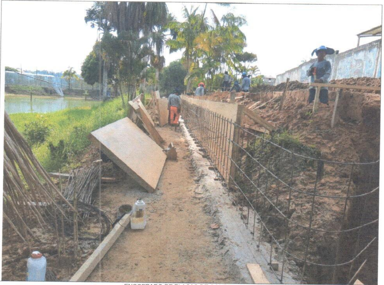
ENCOFRADO DE PLACAS DE CONTENCIÓN
