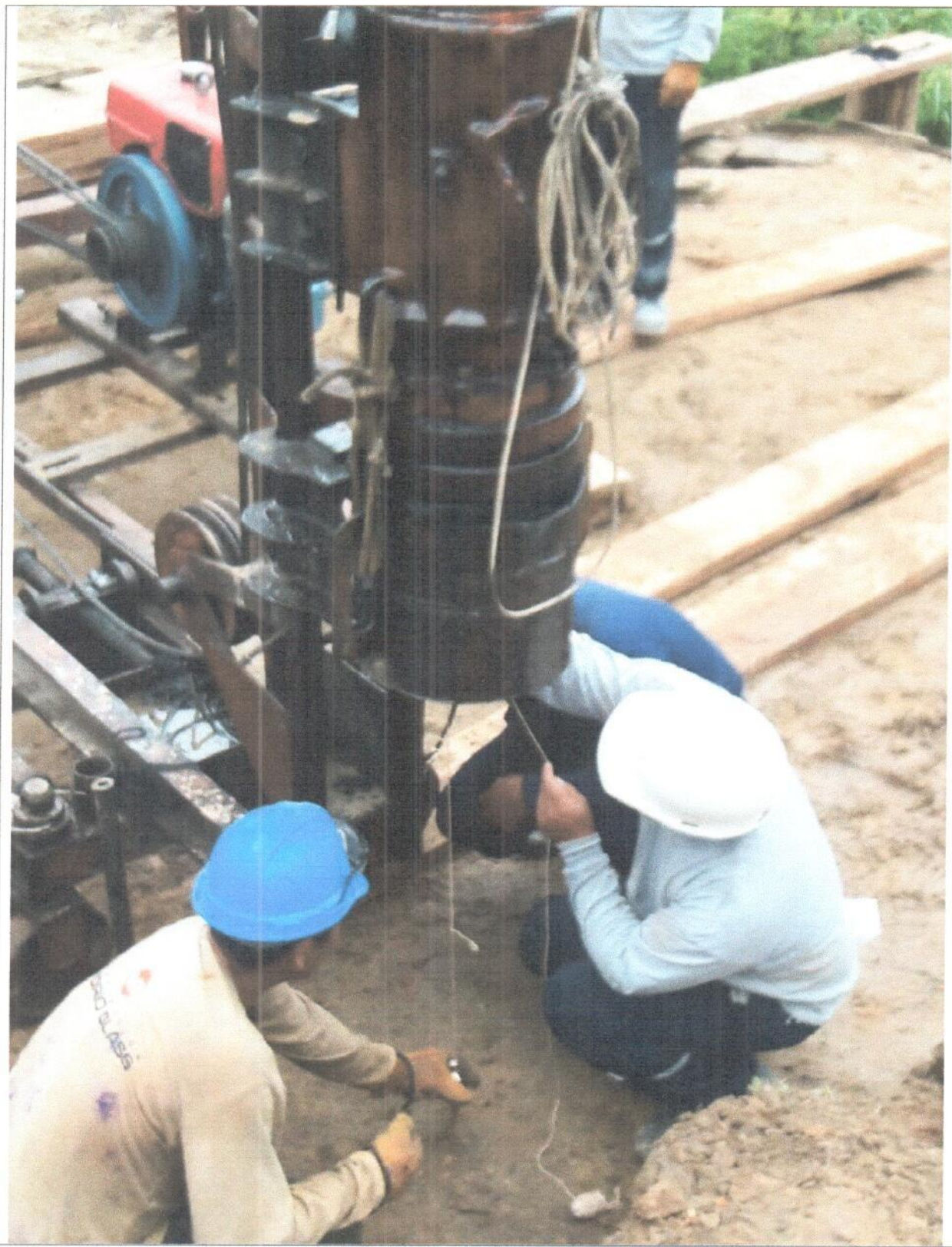
COLOCACION DE PILOTES
